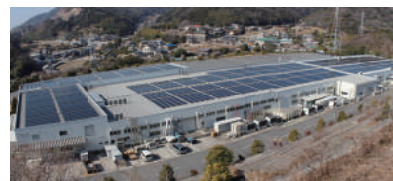
大沢工場 太陽光パネル
