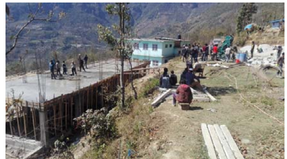
再建工事の様子(2017年3月)
